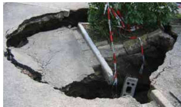
Abb. 5: Der Tagesbruch hat sich eine Stunde später voll ausgebildet
